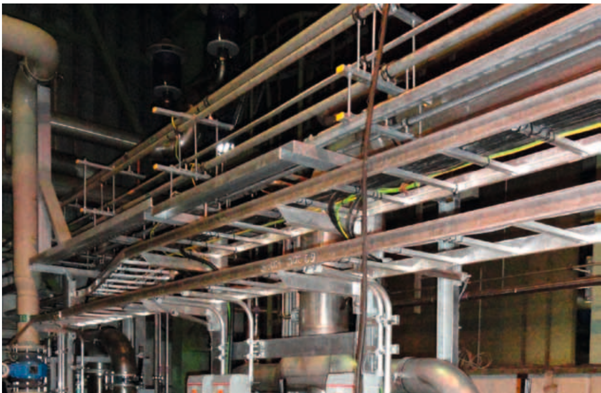
Stav kabelových lávek po 20letém použití v chemickém průmyslu
