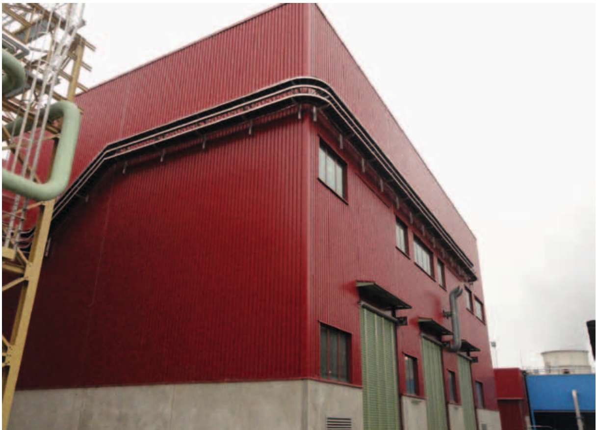
Ukázka vedení kabelových tras vně budovy (kolem opláštění budovy)
