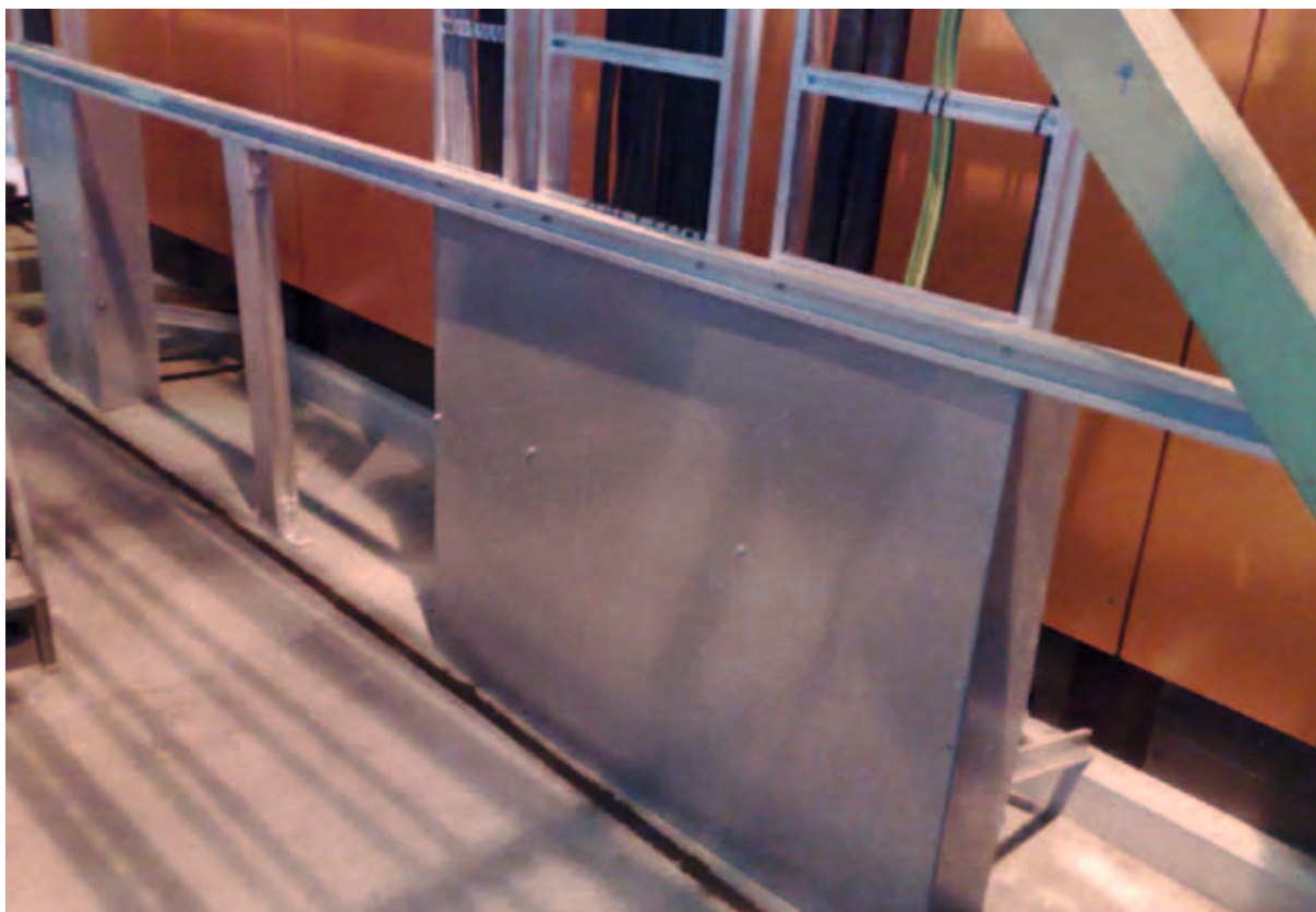
Ukázka ochrany kabelů proti mechanickému poškození pomocí hliníkového plechu
