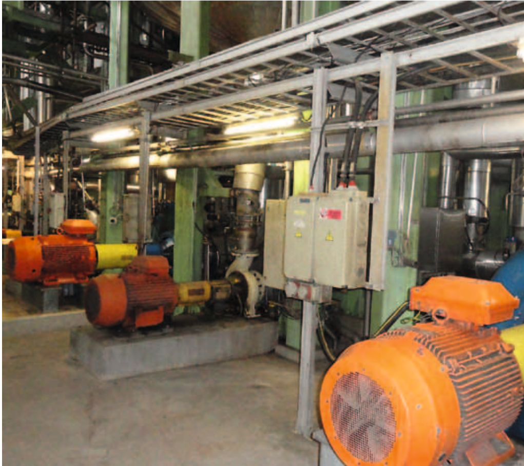
Stav kabelových lávek po 20letém použití v chemickém průmyslu
