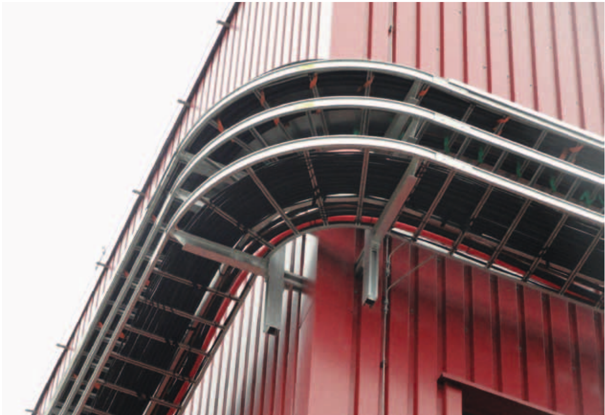
Ukázka vedení kabelových tras vně budovy (kolem opláštění budovy)
