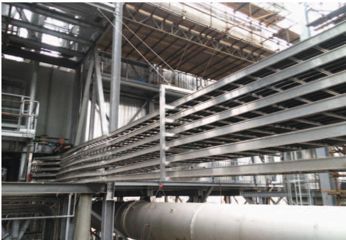
Pohled na uchycení kabelových tras pomocí ocelových lan – při velké rozteči podpěr
