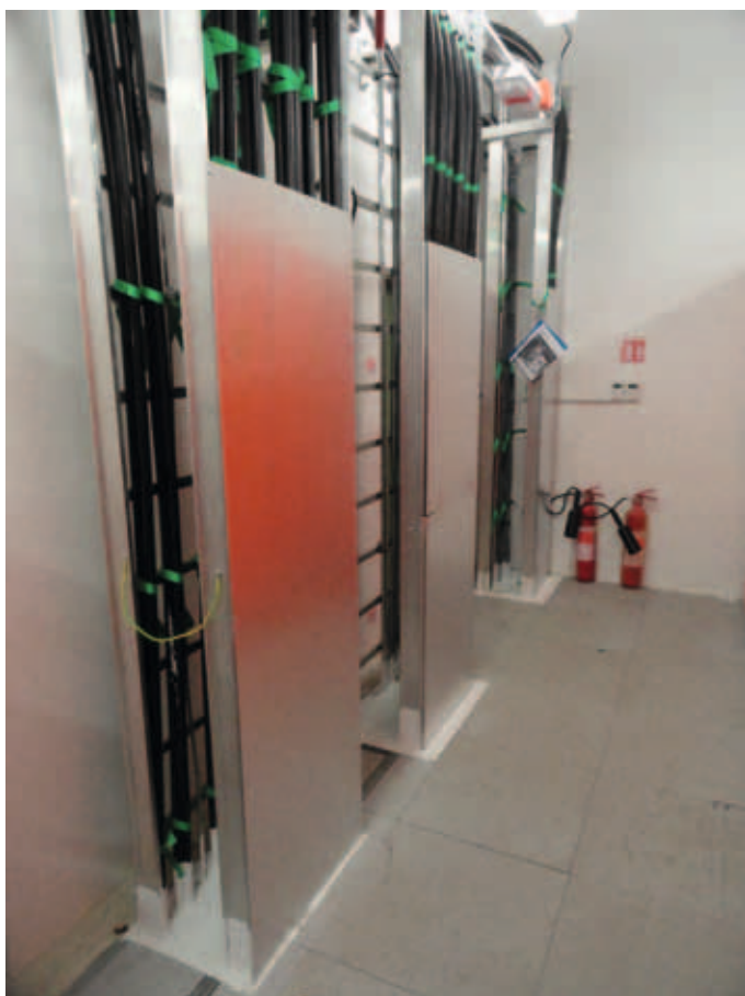
Ukázka ochrany kabelů proti mechanickému poškození pomocí hliníkového plechu
